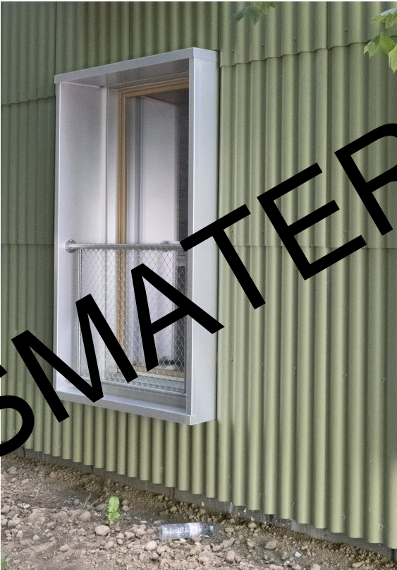
FASAD MED SINUSKORRUGERAD PLÅT FÖNSTER MED MARKERAD RAM
