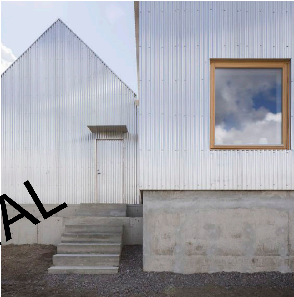
FASAD MED SINUSKORRUGERAD PLÅT, OBEHANDLAD ALUMINIUM SMÄCKRA TAKFÖTTER, VINDSKIVOR. BETONGSOCKEL. FÖRSTBERG LING, HOUSE FOR MOTHER
